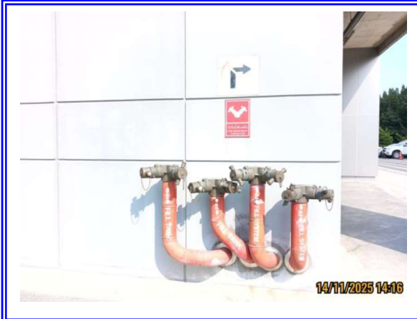
รูปที่ 3-46 หัวรับน้ำดับเพลิงภายนอกอาคาร
