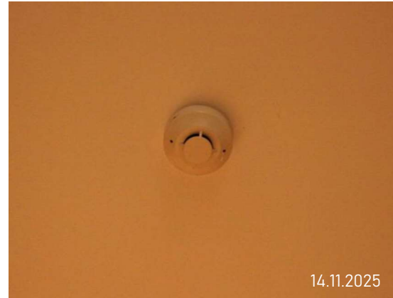
รูปที่ 3-53 เครื่องตรวจจับควัน (Smoke Detector)
