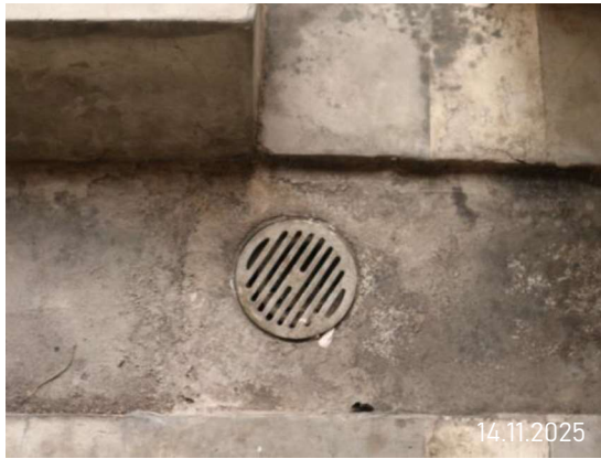
รูปที่ 3-68 ตะแกรงปิดรูท่อระบายน้ำ
