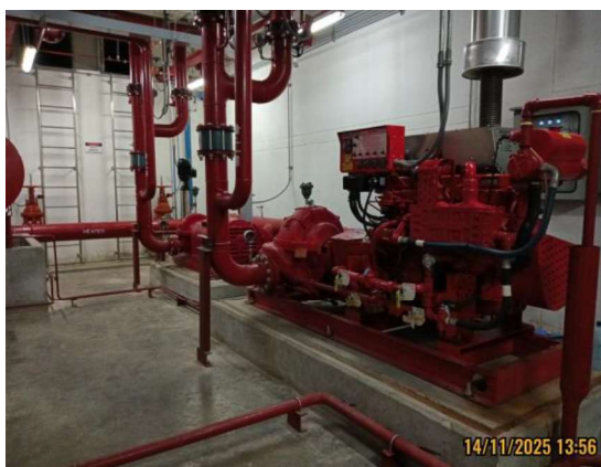
รูปที่ 3-44 เครื่องสูบน้ำดับเพลิง
