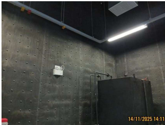
รูปที่ 3-37 ติดตั้งวัสดุกันเสียงภายใน ห้องเครื่องกำเนิดไฟฟ้า
