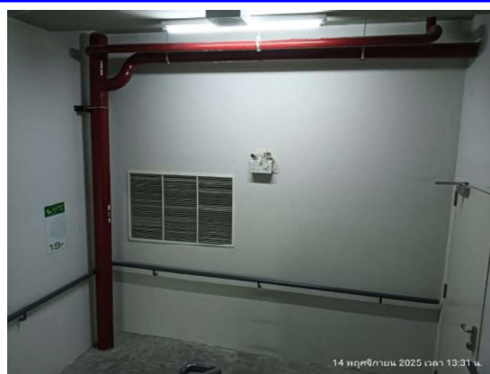
รูปที่ 3-45 ระบบท่อดับเพลิง
