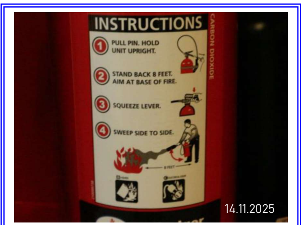
รูปที่ 3-49 ป้ายแสดงรายละเอียดวิธีการใช้งานถังดับเพลิง
