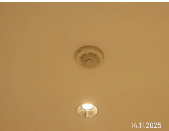
รูปที่ 3-54 เครื่องตรวจจับความร้อน (Heat Detector)
