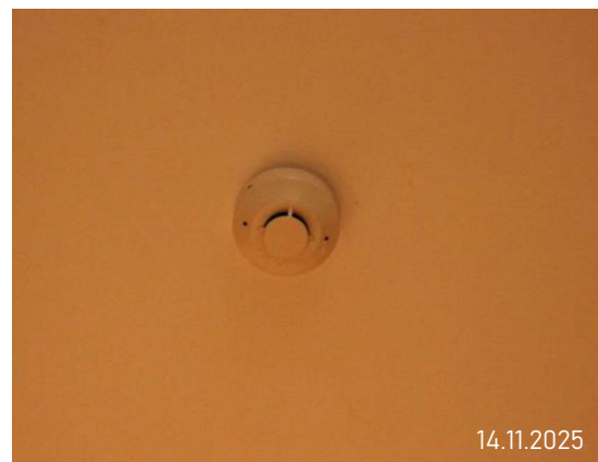
รูปที่ 3-40 เครื่องตรวจจับควัน (Smoke Detector) ภายในห้องหม้อแปลงไฟฟ้า
